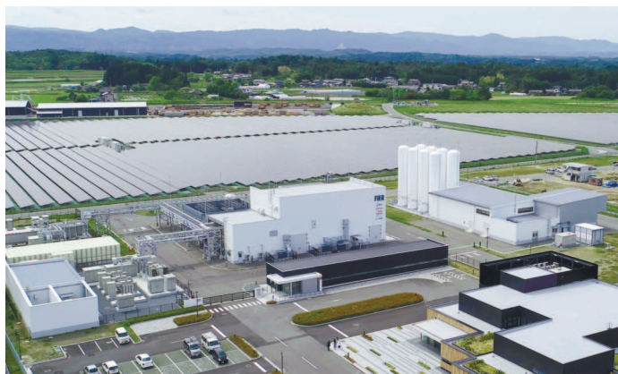
福島水素エネルギー研究フィールド（FH2R）全景
