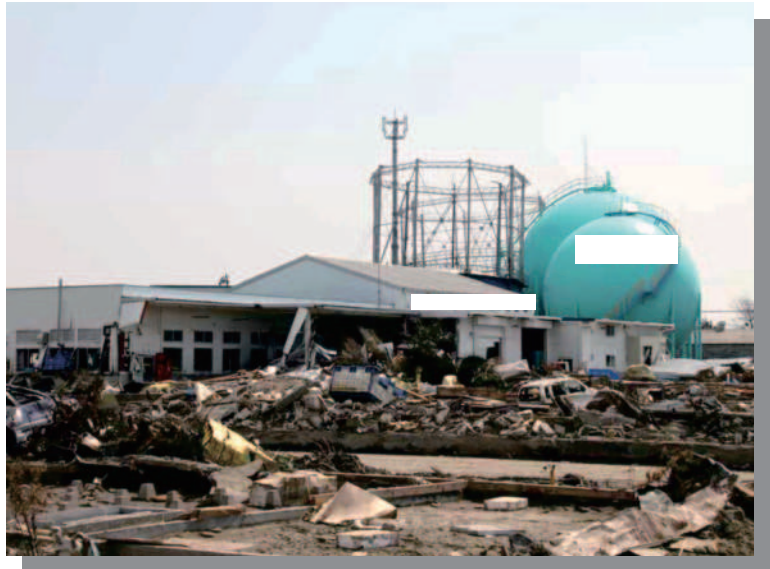
4.11 石巻 被災した都市ガス設備
