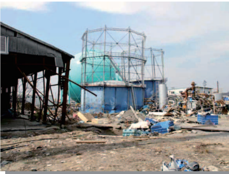
4.12 石巻 被災した都市ガス設備
