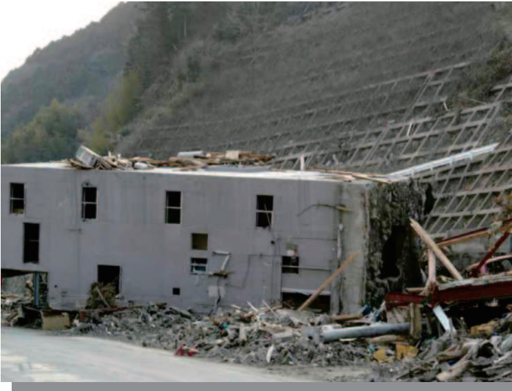
5.4 女川 転倒したビル (右側が1階部分)
