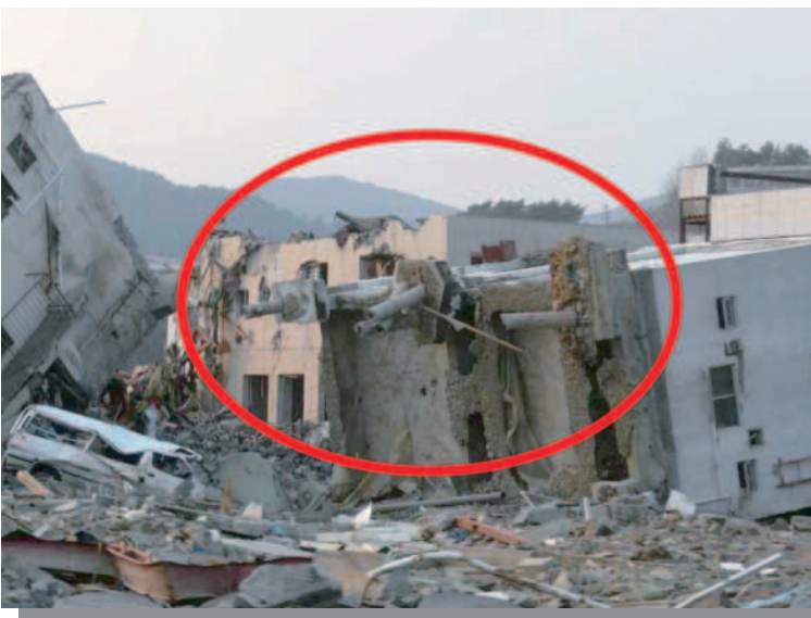
5.6 女川 転倒したビル (基礎杭が確認できる。)
