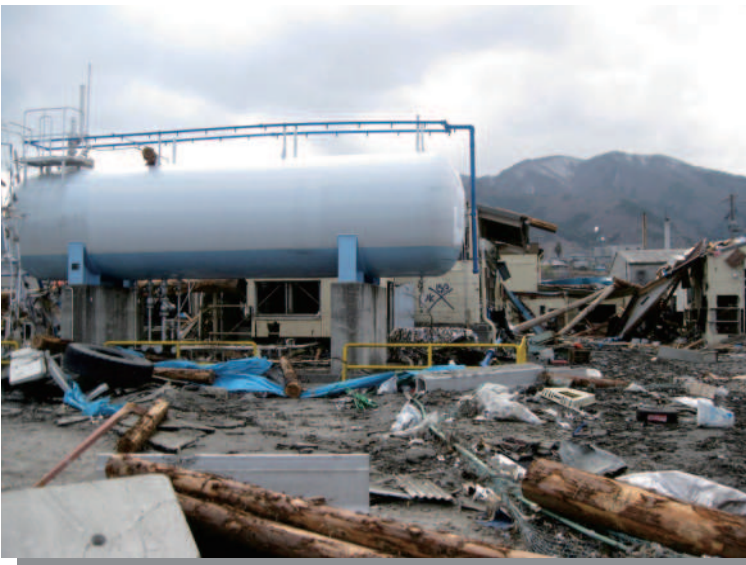
7.21 大船渡 津波により被災した充てん場
