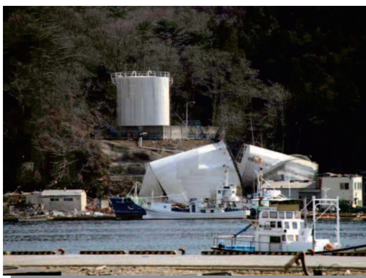
5.3 女川 被災した石油タンク
