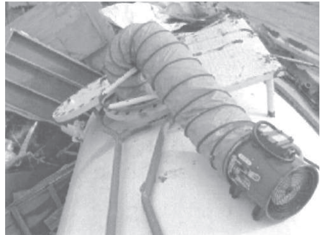
図3-6 貯槽ガス置換作業(2) (送風機にて空気置換実施)
