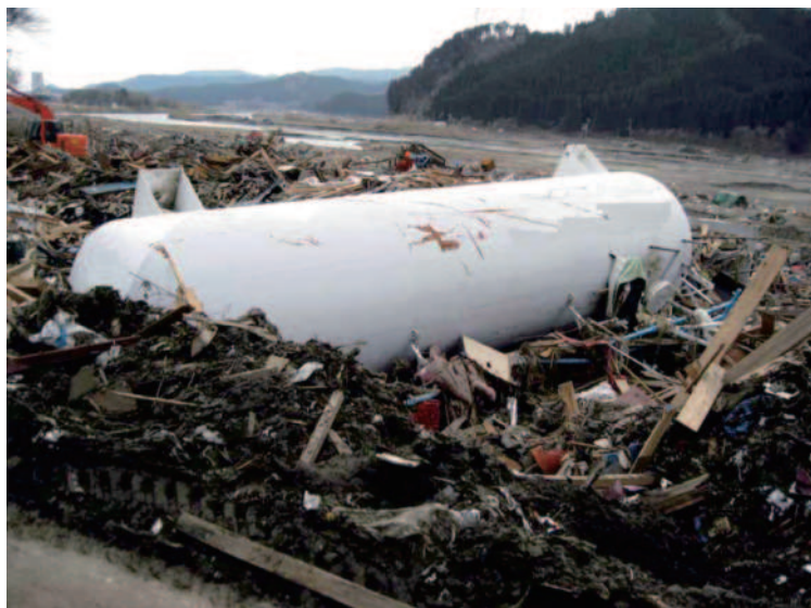
8.8 陸前高田 流出したLPG貯槽
