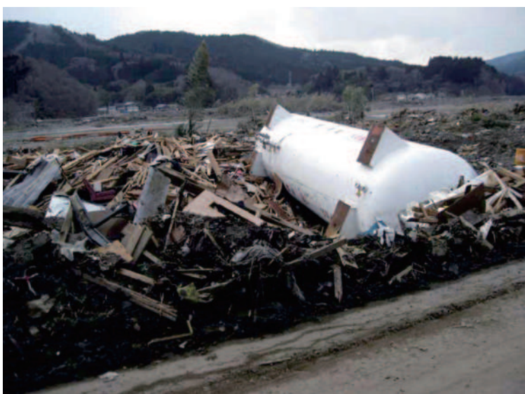
8.8 陸前高田 流出したLPG貯槽
