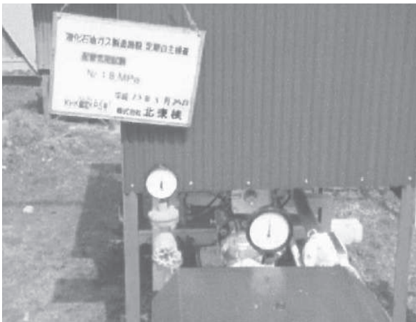
図3-9 配管気密試験
