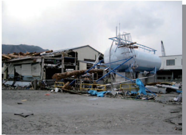
7.20 大船渡 津波により被災した充てん場
