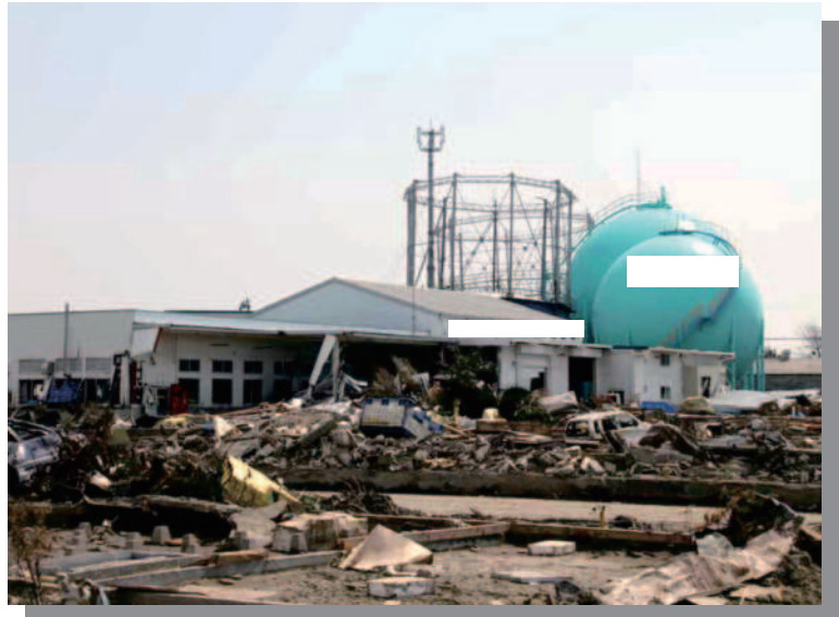
4.11 石巻 被災した都市ガス設備
