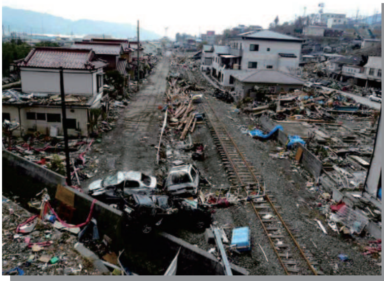
7.1 大船渡駅付近の被災状況 (前方が海岸)
