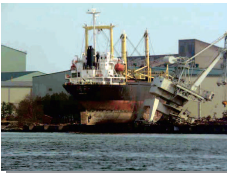
1.18 仙台港 大型貨物船（5,472 t）が陸上に乗揚げ、 ガントリークレーンを破壊した。 9月より解体作業を開始
