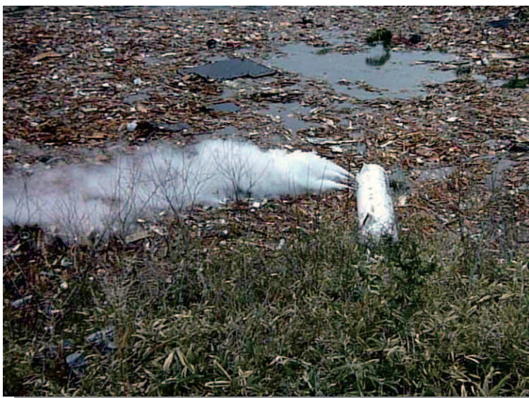
8.7 陸前高田 流出し、LPGを放出する貯槽
