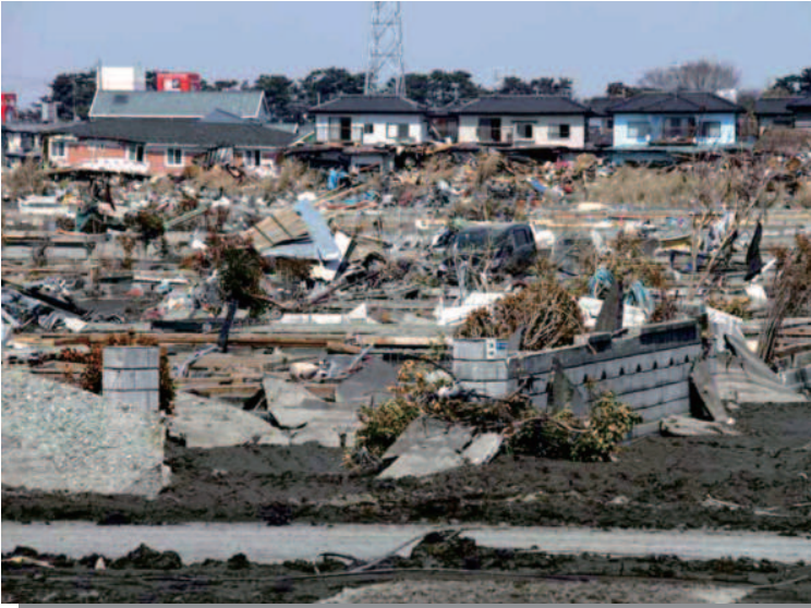
4.10 石巻 被災した住宅地域
