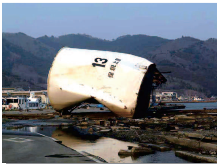
5.2 女川 転倒した石油タンク
