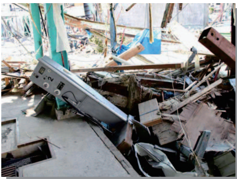
5.14 女川 被災した充填所の転倒した充填設備
