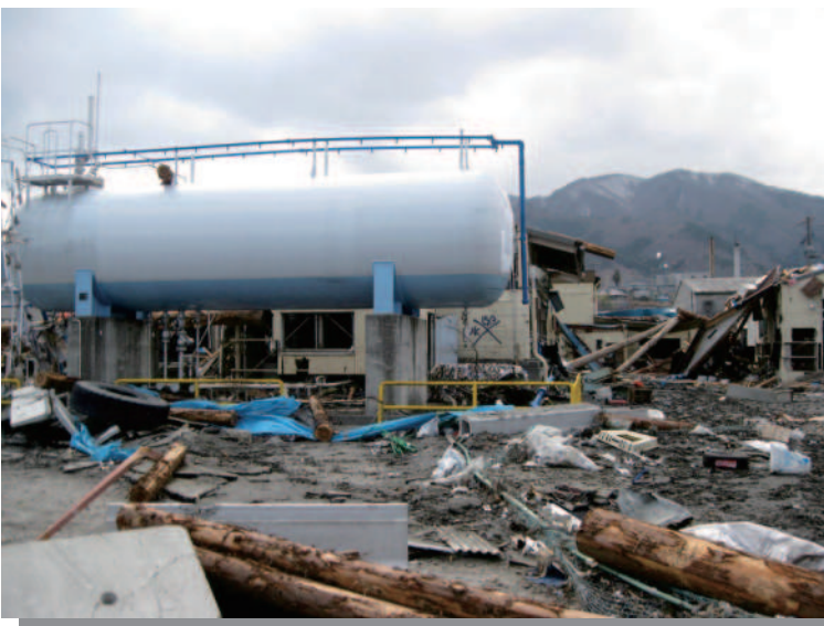
7.21 大船渡 津波により被災した充てん場
