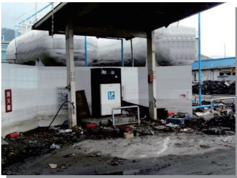
7.3 大船渡 被災した充填所併設のオートガススタンド
