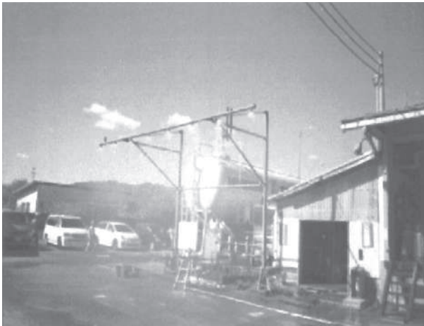
図3-1 貯槽・機械室入口付近（震災前）
