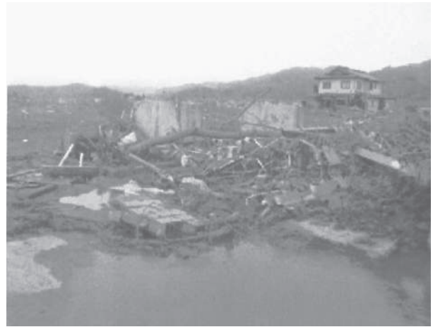
図3-2 貯槽・機械室入口付近（震災後）
