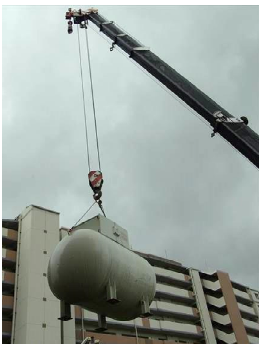
クレーンを使用したバルク貯槽の撤去
