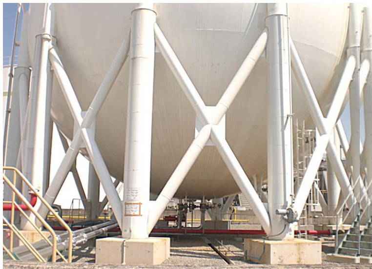
支柱・パイプブレース補強工事
