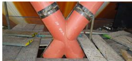
パイプブレース補強工事
