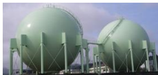
支柱・タイロッドブレース・基礎更新工事
