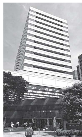
入居ビル全景
